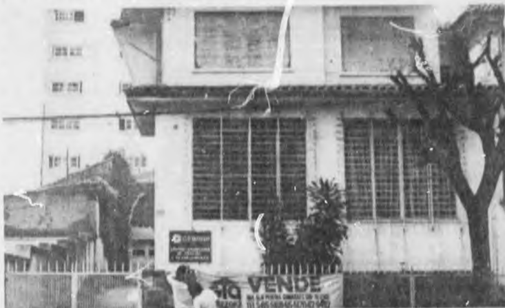
A sede do Cebrap na rua Bahia 499 está num sobrado à venda. A explosão deu-se junto da janela à esquerda.
